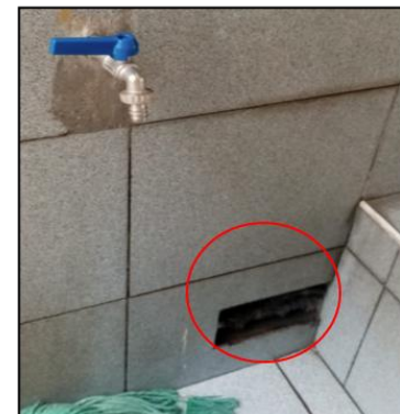
Imagen 10. Punto estructural en llave de paso - Lavadero de mopas administración
